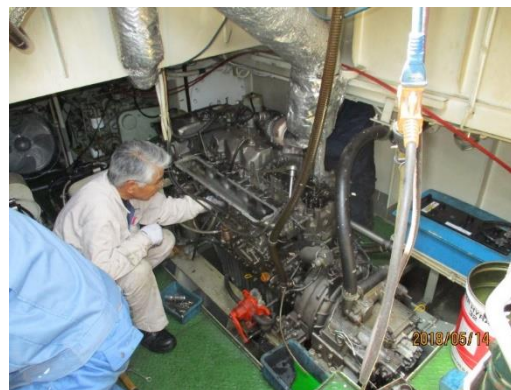
『主機関オーバーホール』
