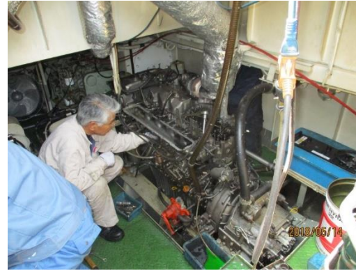
『主機関オーバーホール』
